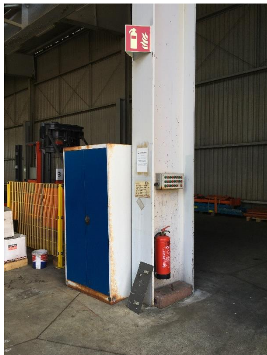
Feuerlöscher im Werk
